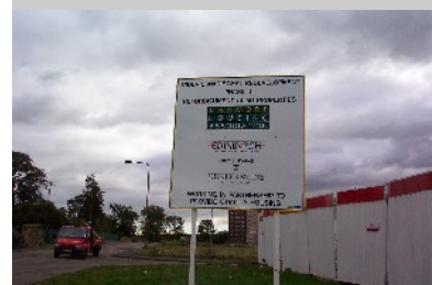
Informationstafel zum Sanierungsvorhaben
